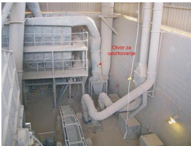
Slika 2 - Merno mesto emitera sistema za drobljenje
