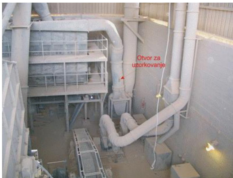
Slika 2 - Merno mesto emitera sistema za drobljenje
