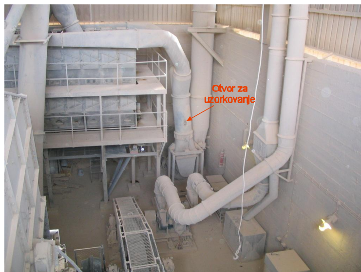
Slika 3 – Merno mesto emitera sistema za drobljenje
