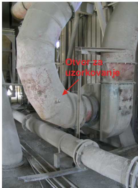
Slika 7 – Mesto za uzorkovanje na emiteru silosa cementa (malog)
