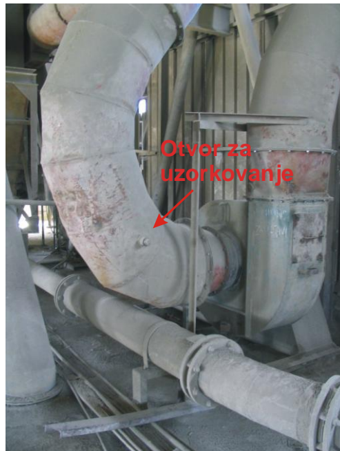
Slika 7. Mesto za uzorkovanje na izlazu iz vrećastog filtera silosa za otprašivanje cisterni
