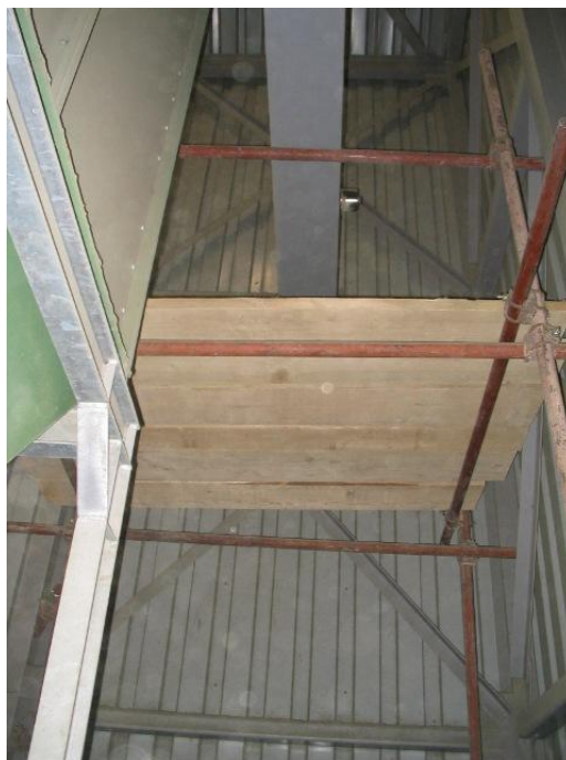
Slika 7 - Merno mesto na izlazu iz vrećastog filtera na presipnoj stanici u presipnoj kuli
