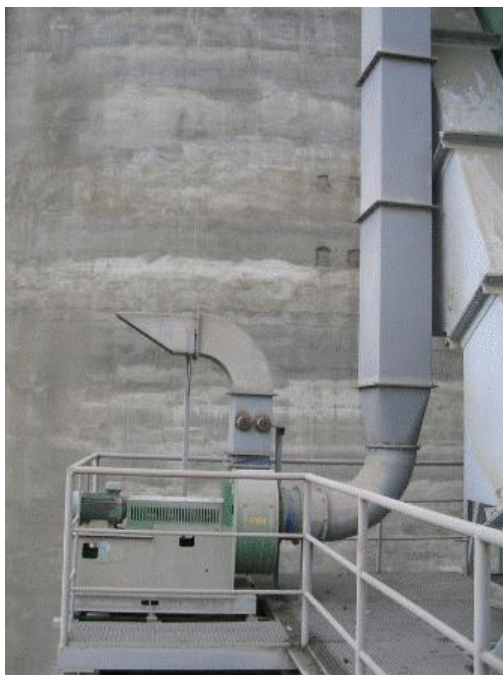
Slika 6 – Mesto za uzorkovanje na emiteru presipne stanice na skladištu klinkera
