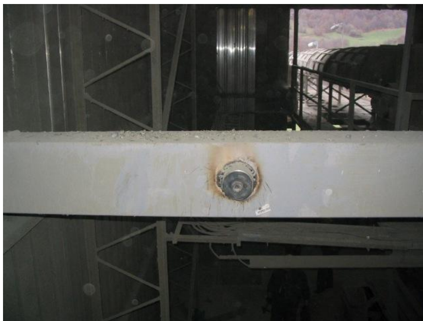
Slika 8. Memo mesto na izlazu iz vrećastog filtera na presipnoj stanici na silosu klinkera
