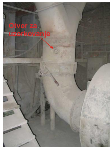
Slika 6 – Mesto za uzorkovanje na emiteru iz mašine za pakovanje cementa
