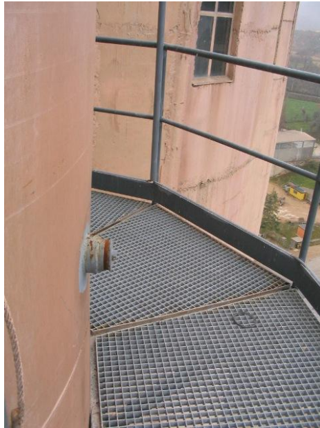
Slika 4 - Merno mesto na izlazu iz elektrofiltera mlina sirovina i rotacione peći
