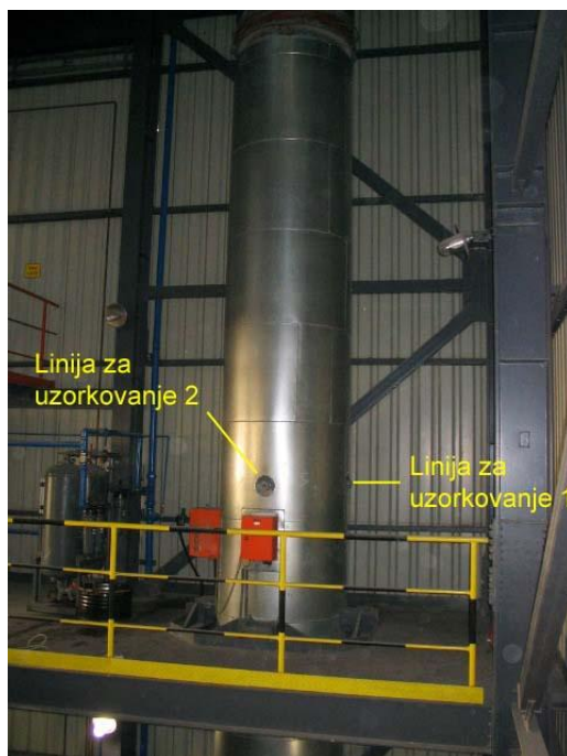
Slika 8 - Merno mesto na izlazu iz vrećastog filtera na mlinu petrolkokska
