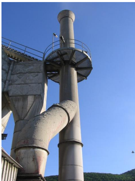
Slika 5. Mesto za uzorkovanje na emiteru mlina cementa
