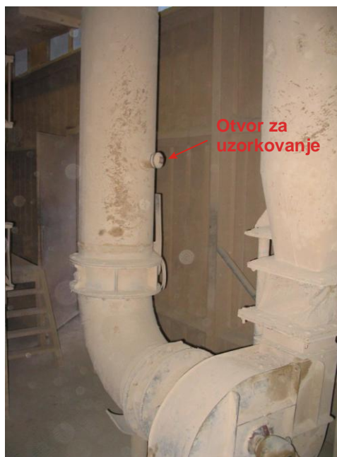
Slika 4. Mesto za uzorkovanje na emiteru vaga za doziranje peći
