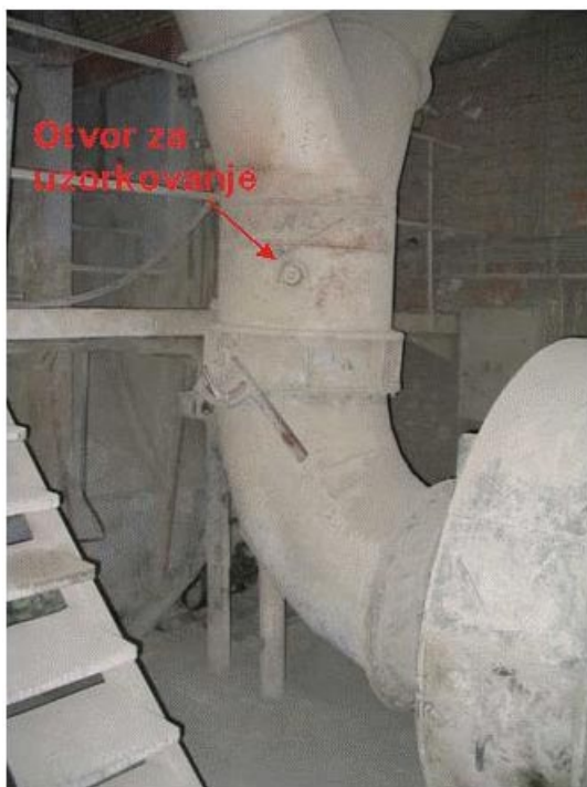
Slika 10 - Mesto za uzorkovanje na emiteru iz mašine za pakovanje cementa
