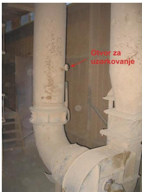
Slika 5 - Mesto za uzorkovanje na emiteru vaga za doziranje peći
