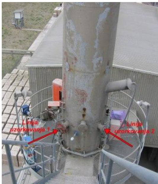
Slika 9 - Mesto za uzorkovanje na emiteru mlina cementa
