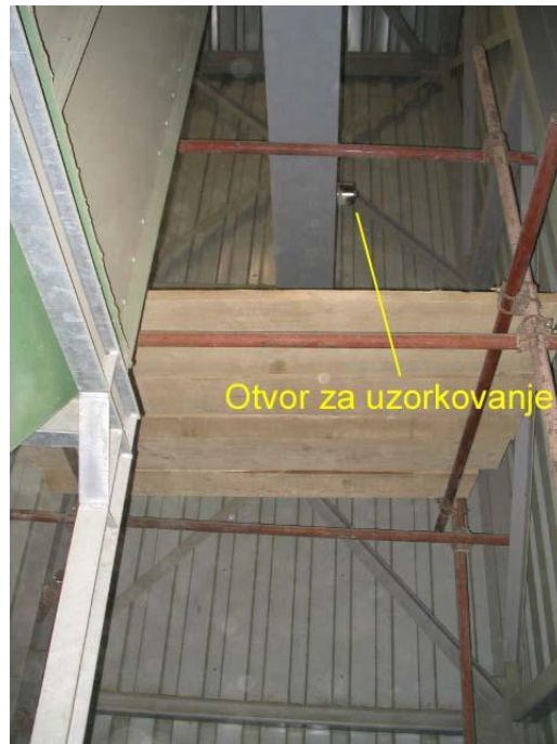
Slika 6 - Merno mesto na izlazu iz vrećastog filtera na presipnoj stanici u presipnoj kuli
