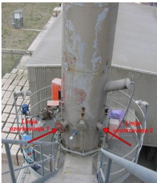
Slika 9 - Mesto za uzorkovanje na emiteru mlina cementa
