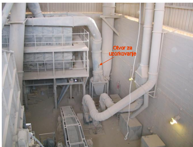
Slika 1. Merno mesto emitera sistema za drobljenje
