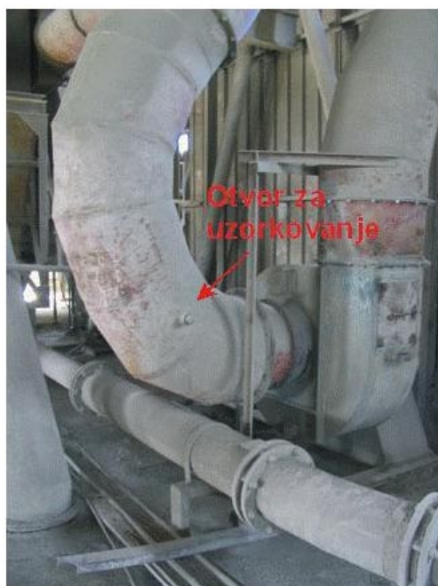
Slika 11 - Mesto za uzorkovanje na izlazu iz vrećastog filtera silosa za odprašivanje cisterni
