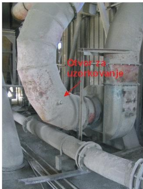
Slika 11 - Mesto za uzorkovanje na izlazu iz vrećastog filtera silosa za otprašivanje cisterni
