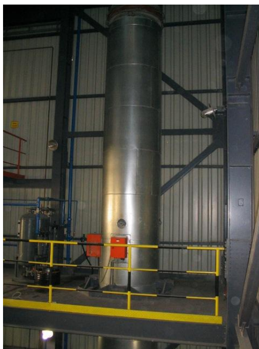
Slika 10. Merno mesto na izlazu iz vrećastog filtera na mlinu petrolkoksa
