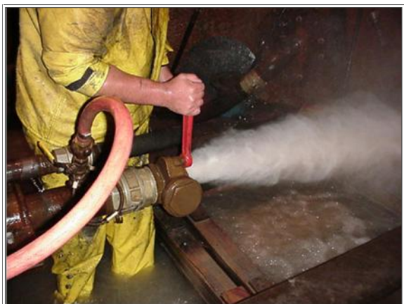
Slika 4 - Postupak razrade drenova brzopoteznim zatvara em (preuzeto sa: www.layne.com )
