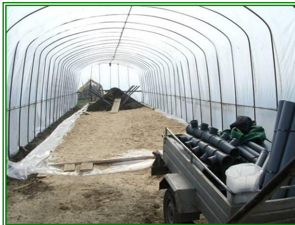
Postavljanje cevi za aeraciju
