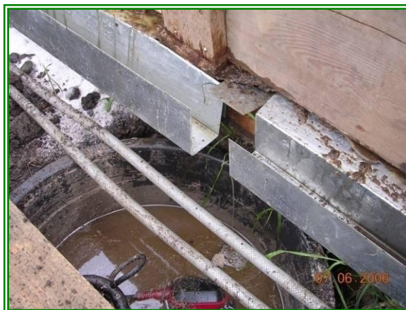
Sistem oluka za sakupljanje procedne tečnosti
