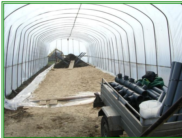
Postavljanje cevi za aeraciju
